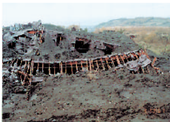
写真5 火山灰・噴石と断層によって破壊された菓子工場。 Photo5 Damaged factory by ash, cinder and faults.
