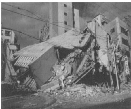
阪神・淡路大震災(1995年1月17日)の際の神戸市中央区におけるビル崩壊状況(首都大学東京・中林一樹教授撮影)
